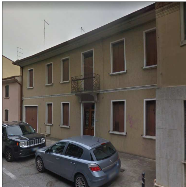
Foto da via Verdi (Corpo A)
