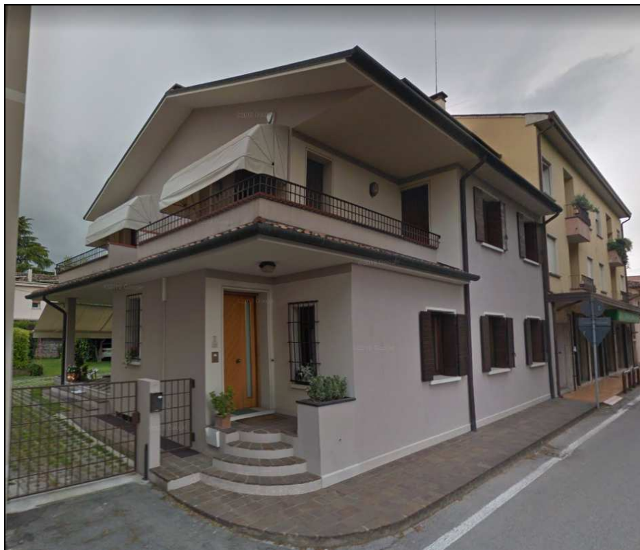
Foto da via Verdi (Corpi A e B)
