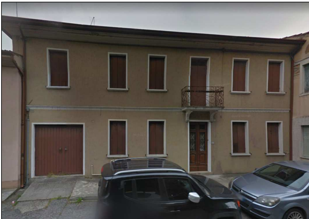
Foto da via Verdi (Corpo A)
