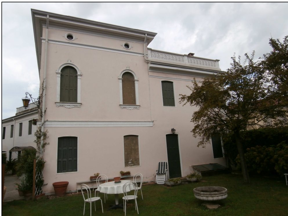
Foto fronte via Menegazzo (Corpo A)
