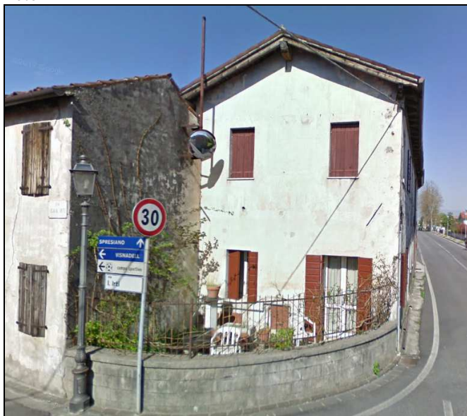
Foto da via Irti – via 1° Maggio (Corpo A)
