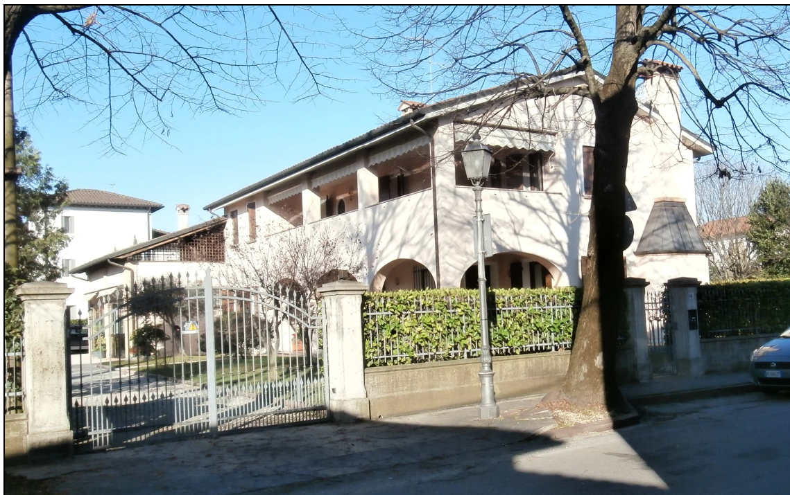
Foto da via Irti
