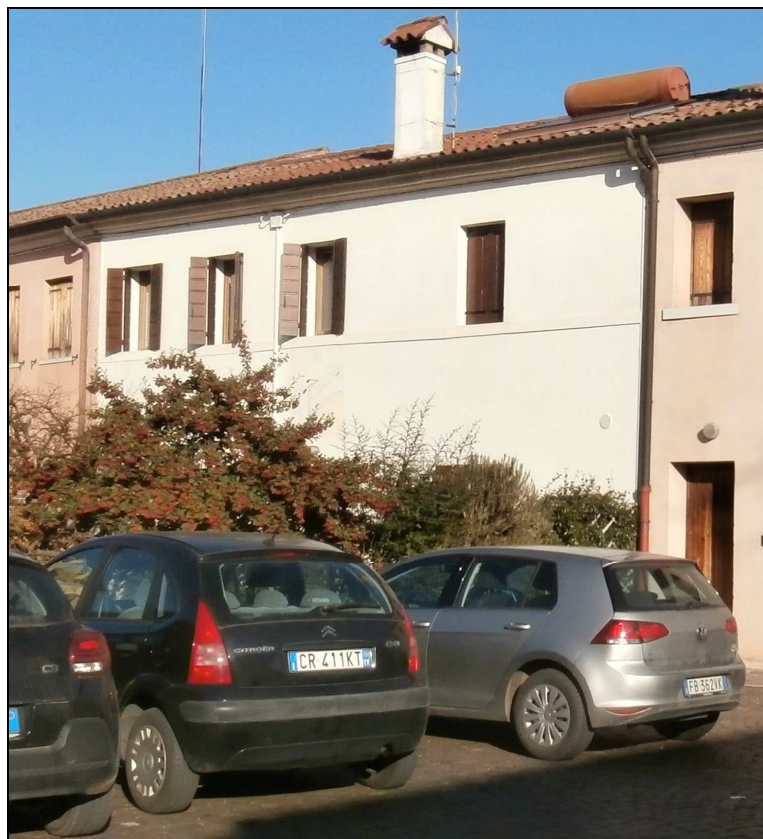
Foto da via Irti
