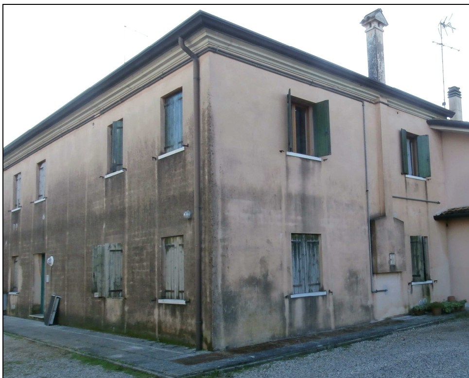
Foto da interno via Irti
