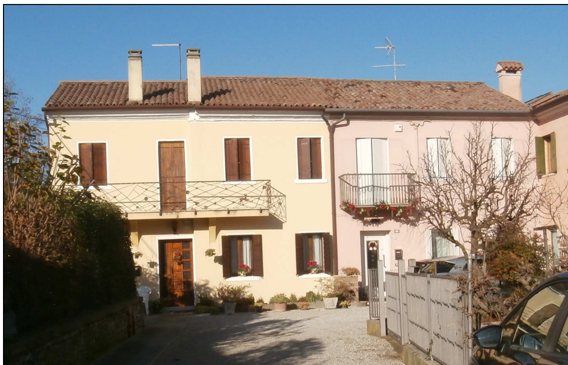
Foto da via Irti
