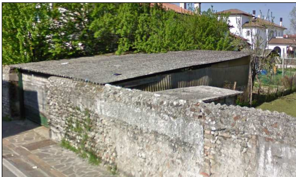
Foto da via Irti (Corpo A)
