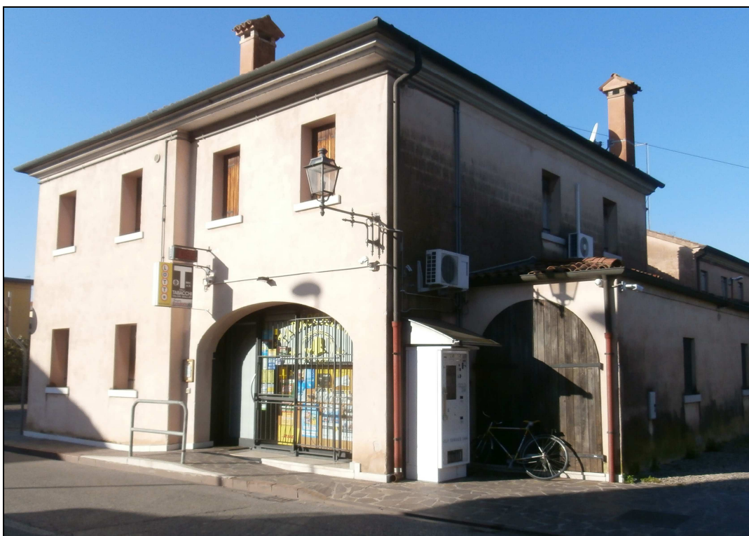
Foto da via Irti
