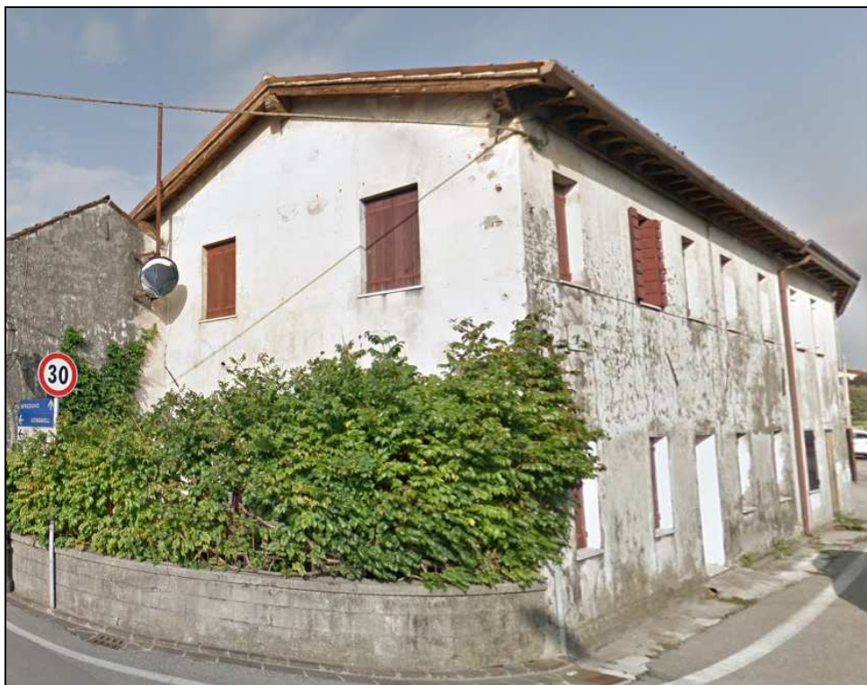
Foto da via Irti – via 1° Maggio (Corpo A)
