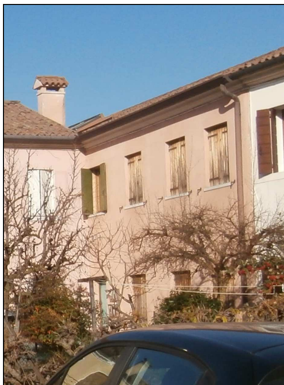
Foto da via Irti
