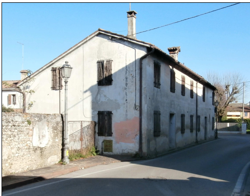
Foto da via Irti
