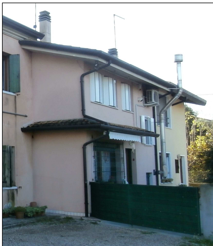
Foto da interno via Irti
