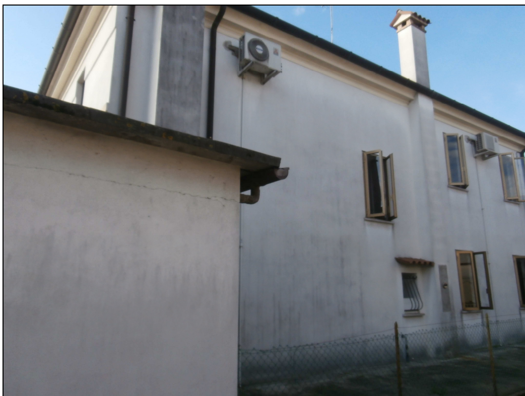
Foto da via Lovarini (Corpo A)
