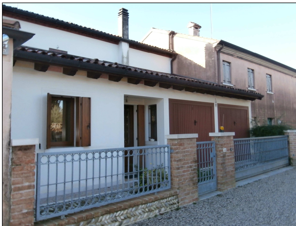
Foto da interno via Irti
