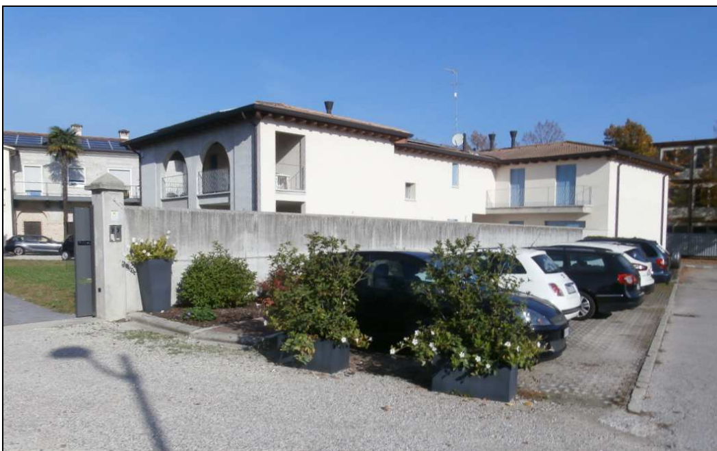
Foto da via Lazzaris (Corpi B e C)
