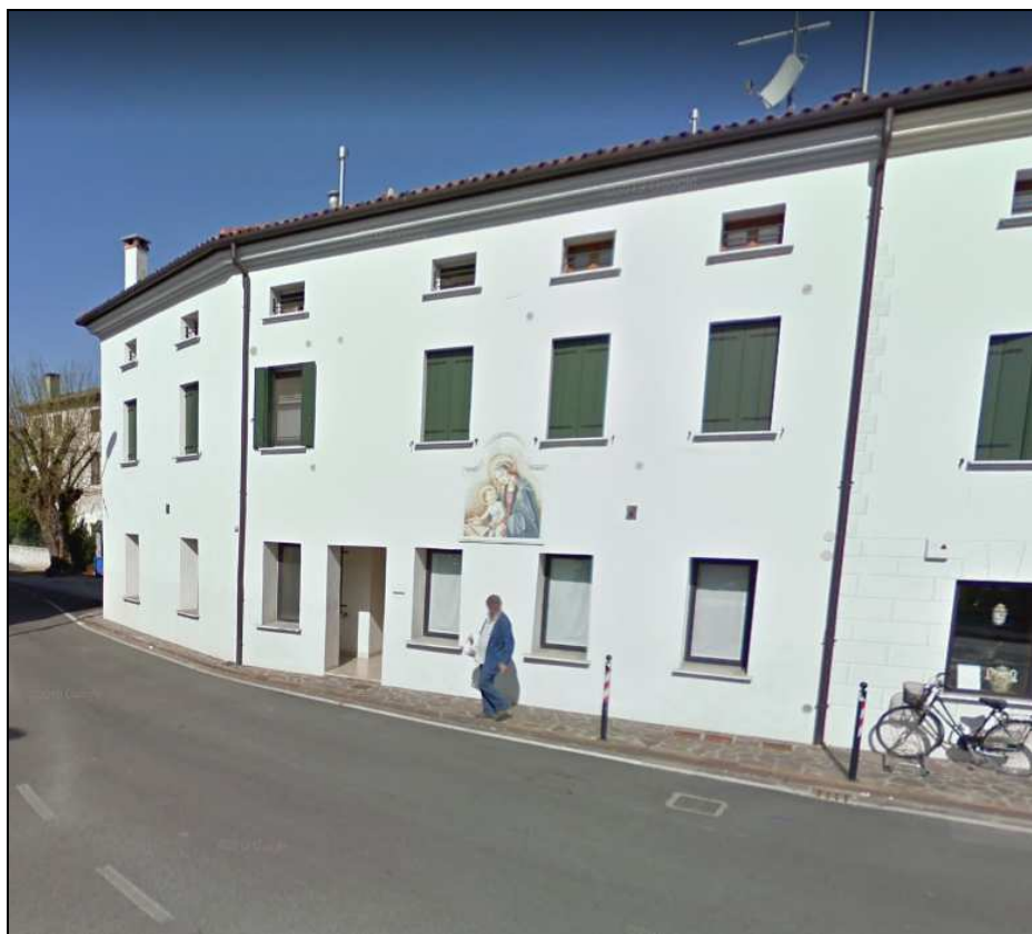
Foto da Via Irti
