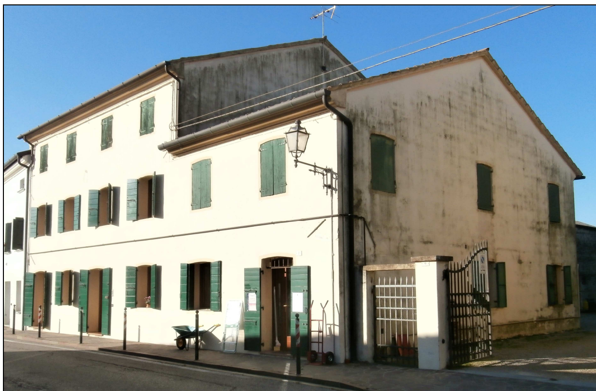
Foto da Via Irti
