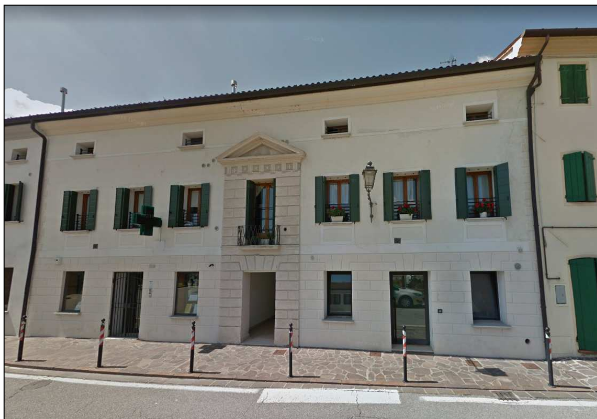
Foto da Via Irti
