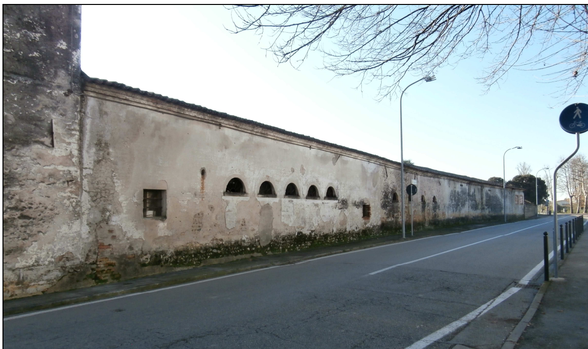
Foto da via IV Novembre (Corpo A)
