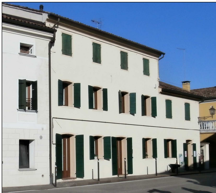
Foto da Via Irti
