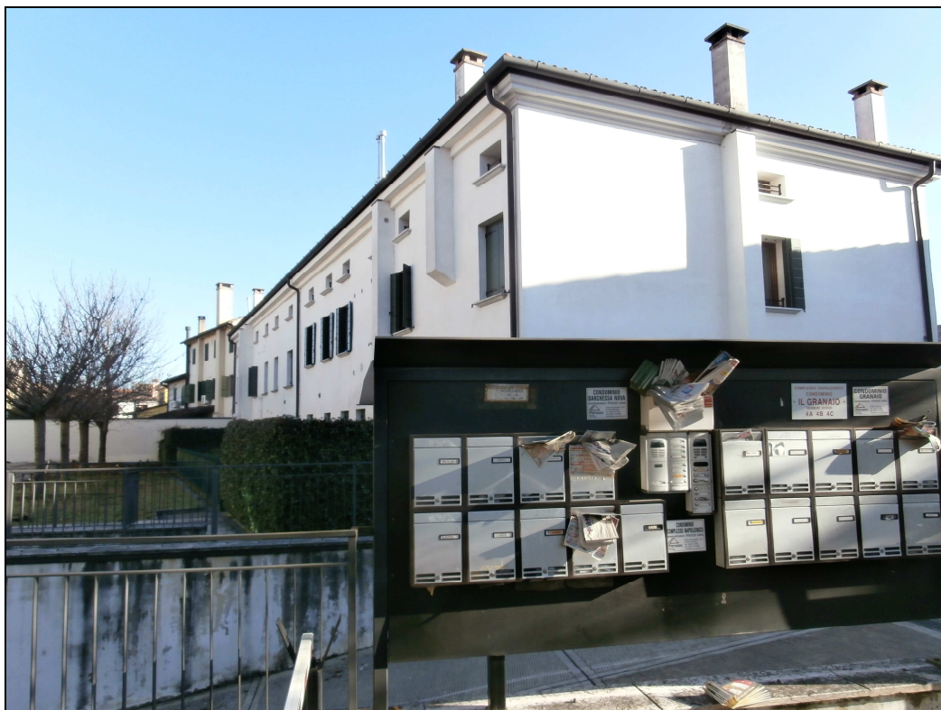
Foto da interno Via IV novembre
