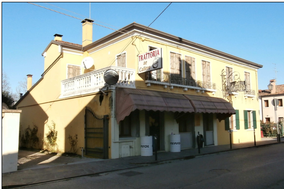
Foto da Via Irti
