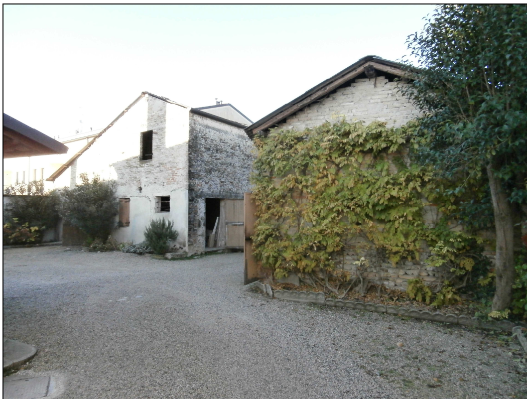
Foto da interno Via Irti
