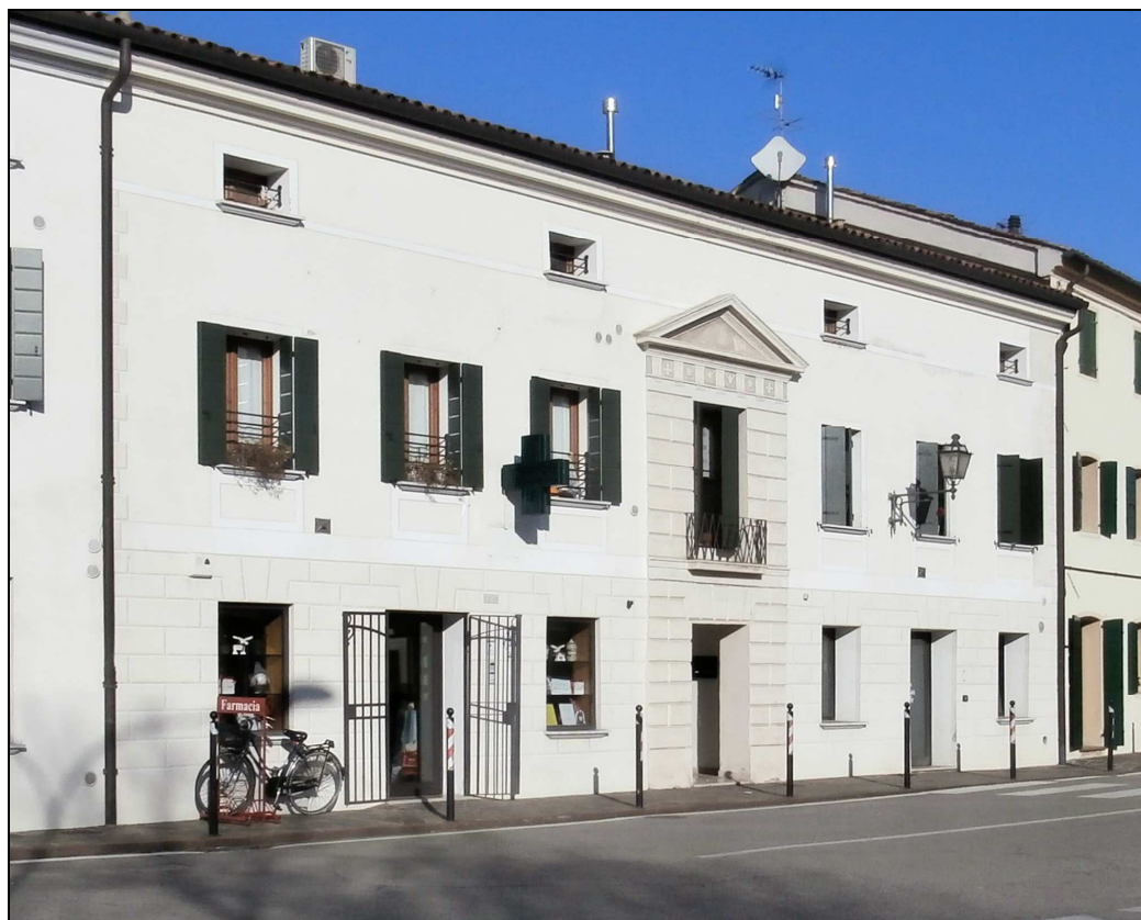
Foto da Via Irti
