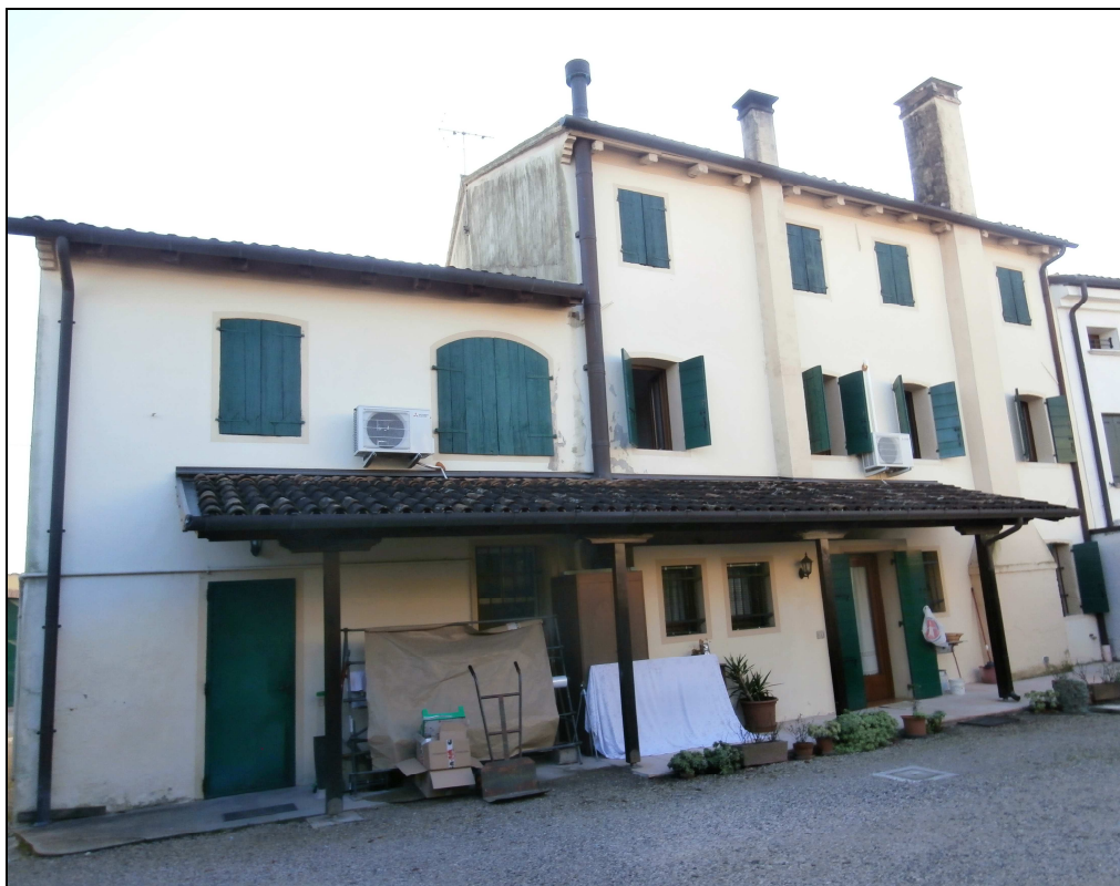
Foto da interno Via Irti
