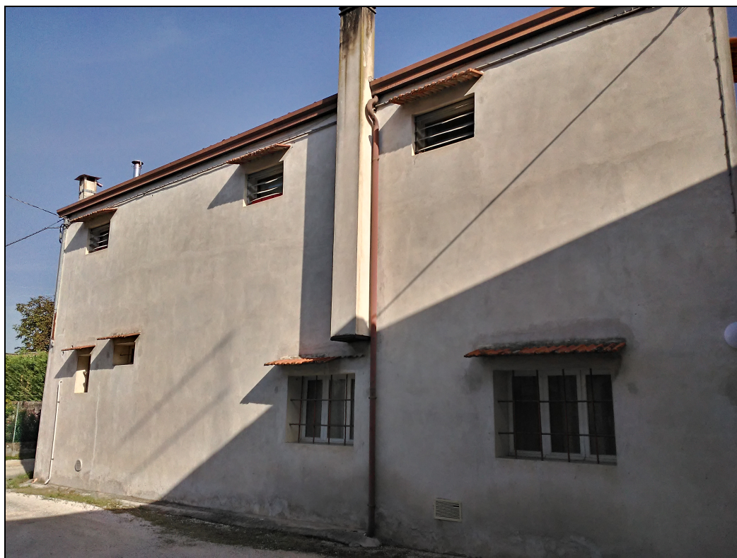
Foto interna da via Calessani (Corpo A)
