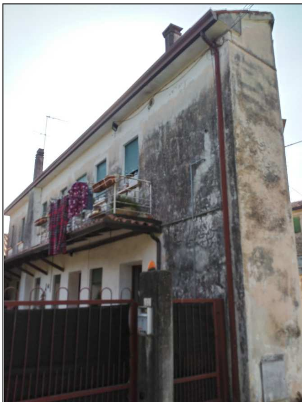
Foto interna da via Calessani (Corpo A)
