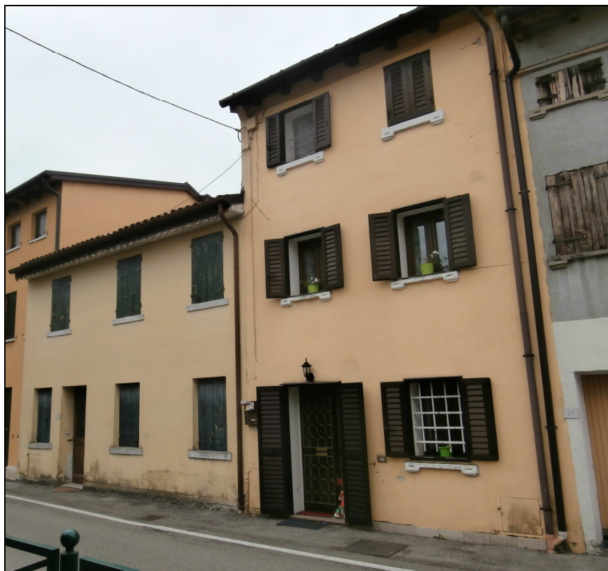
Foto da via Cavour (Corpo A)
