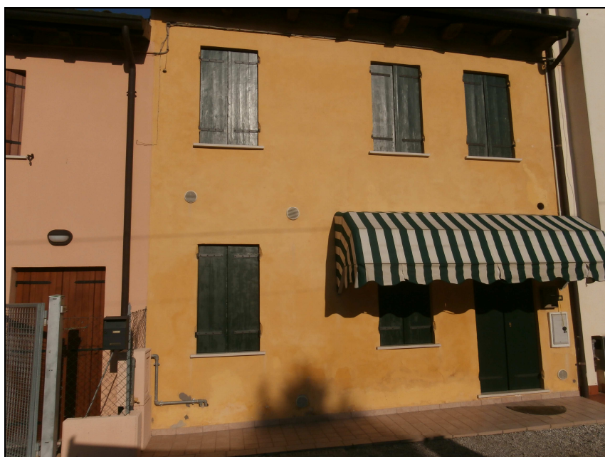
Foto interna da via Cavour
