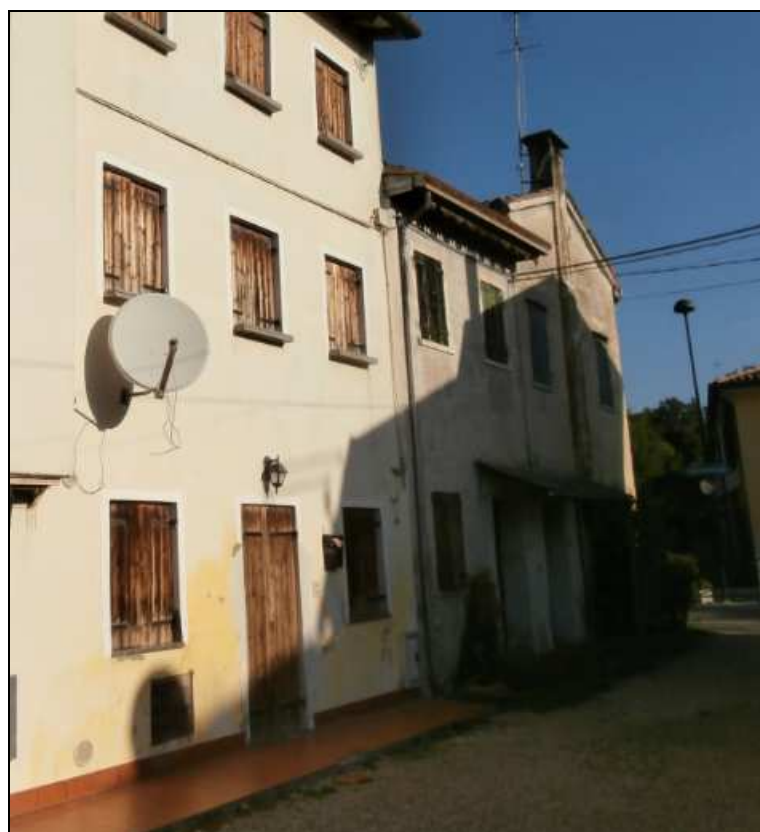
Foto interna da via Cavour
