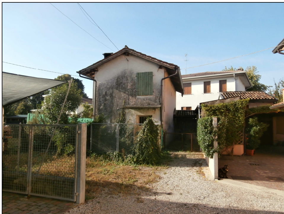
Foto interna da via Cavour (Corpo C)
