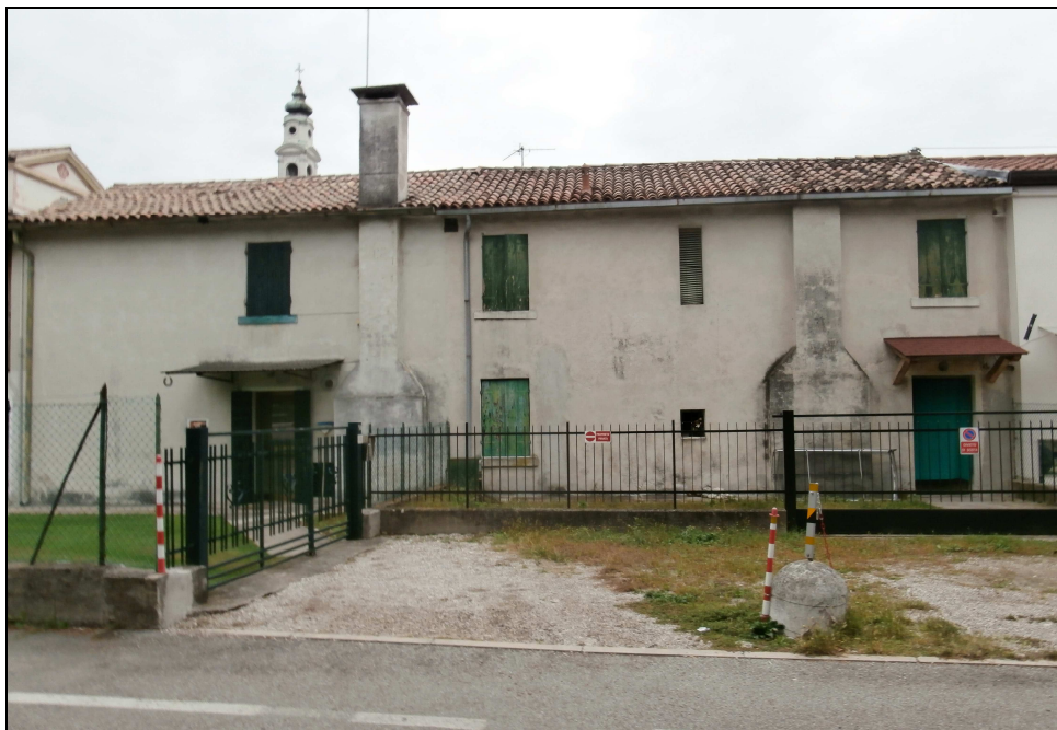
Foto interna da via Cavour
