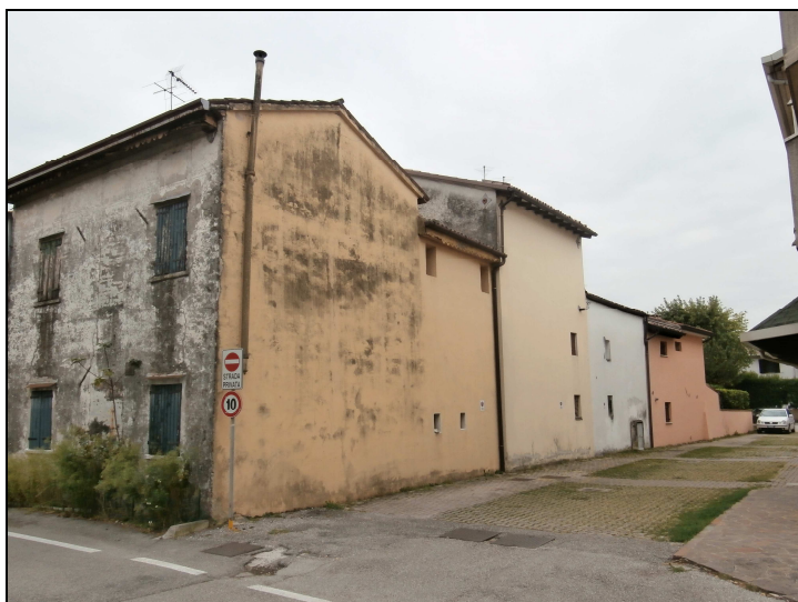
Foto da via Cavour (Corpo A)
