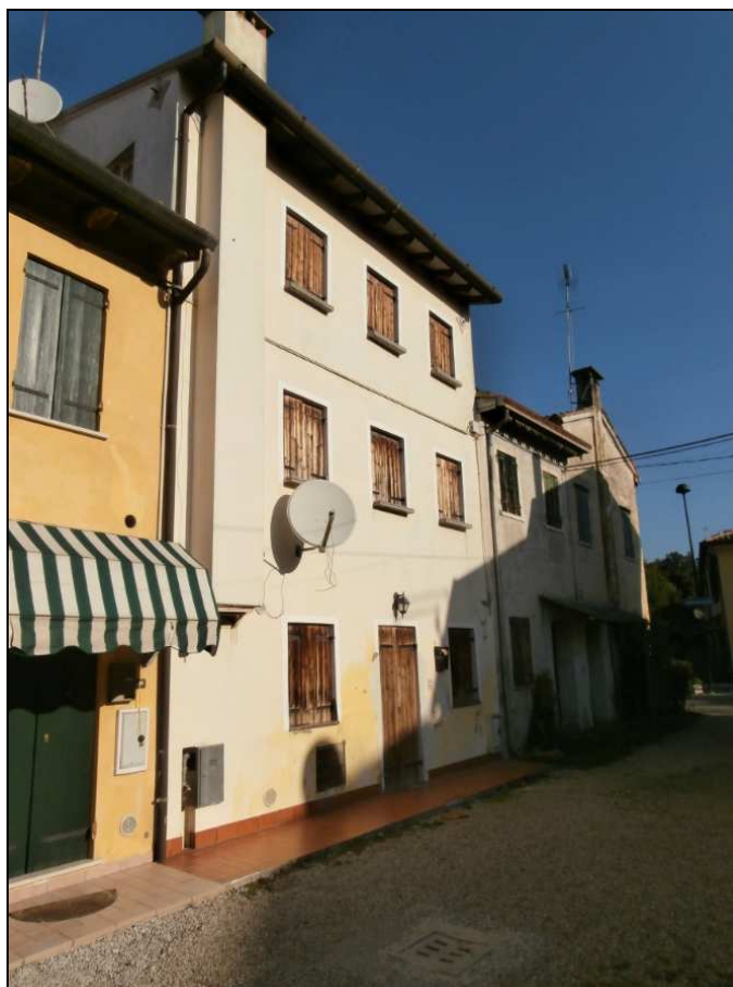
Foto interna da via Cavour
