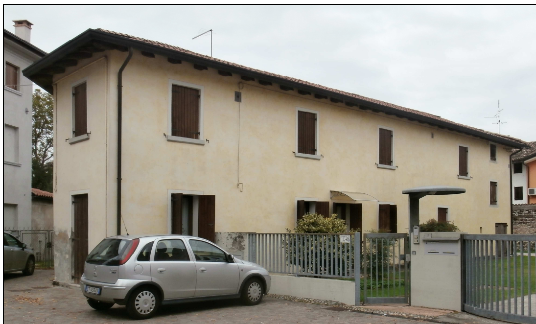
Foto da via Cavour (Corpo A)
