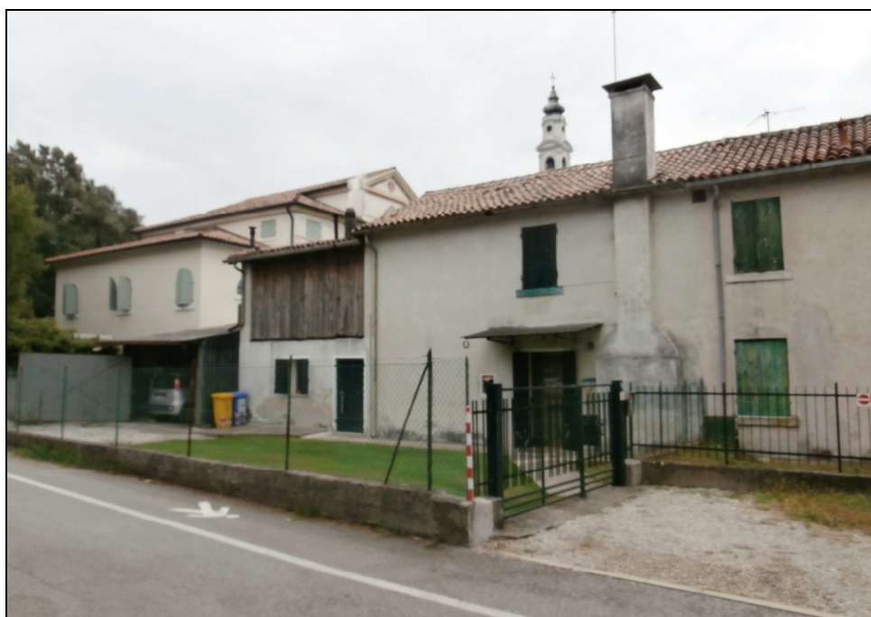
Foto interna da via Cavour
