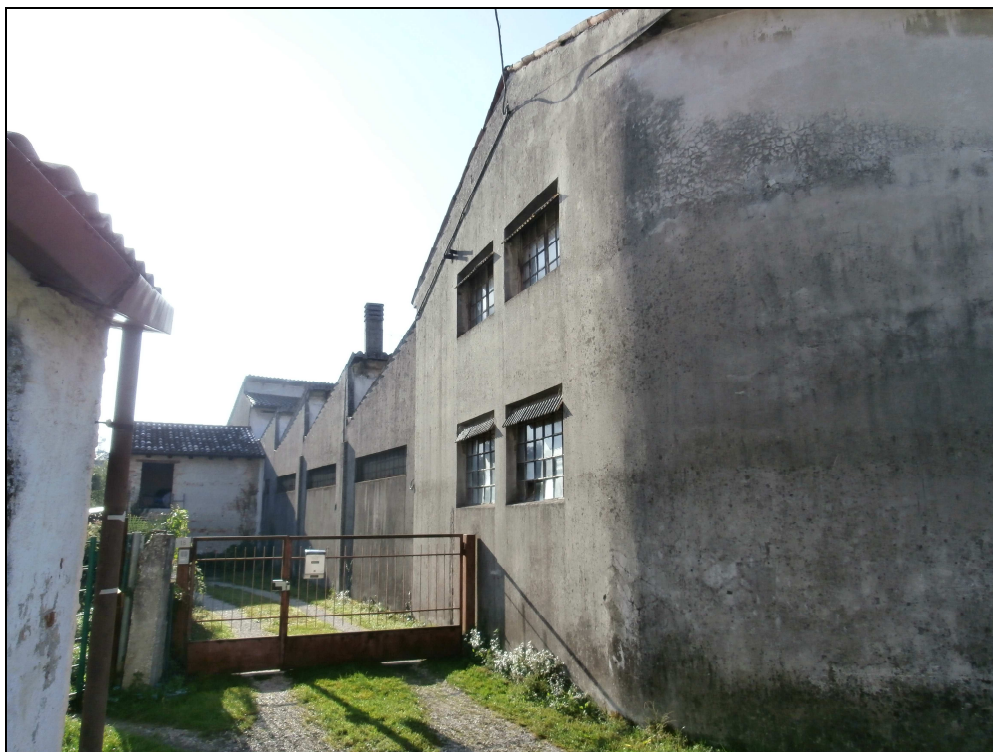
Foto interna da via Cavour
