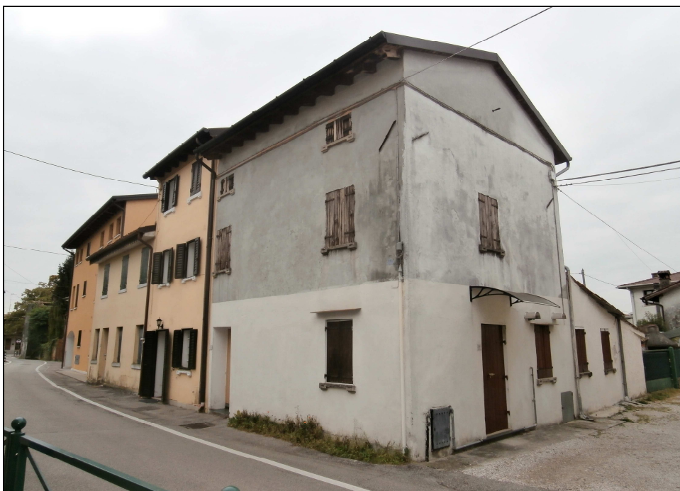
Foto da via Cavour (Corpo A)
