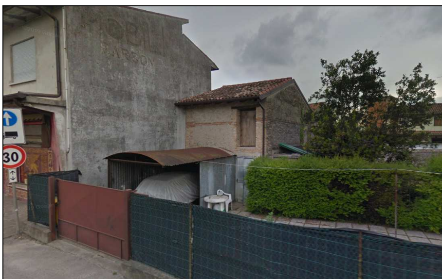
Foto da via S. Pio X (Corpo C)
