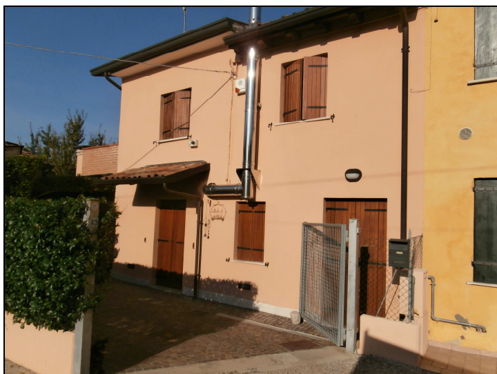
Foto da interno via Cavour (Corpo A)
