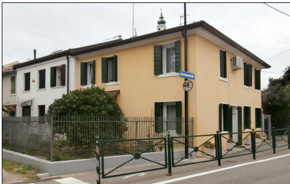
Foto da via Cavour (Corpo A)
