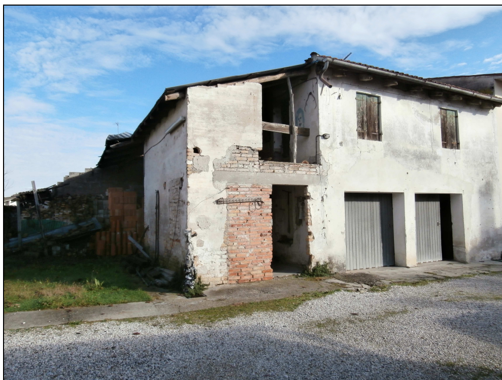
Foto interna da via Lovarini (Corpi A e B)
