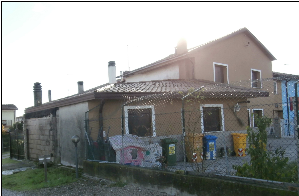
Foto interna da via Lovarini (Corpo B)
