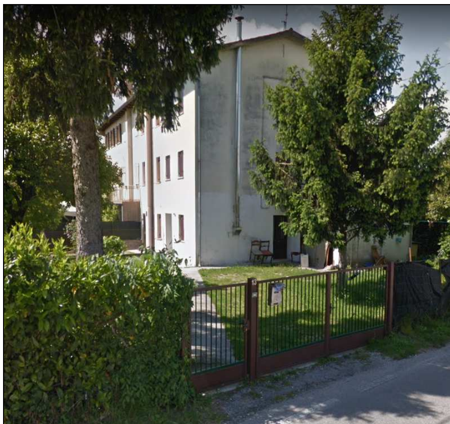
Foto da via Lovarini (Corpo A)
