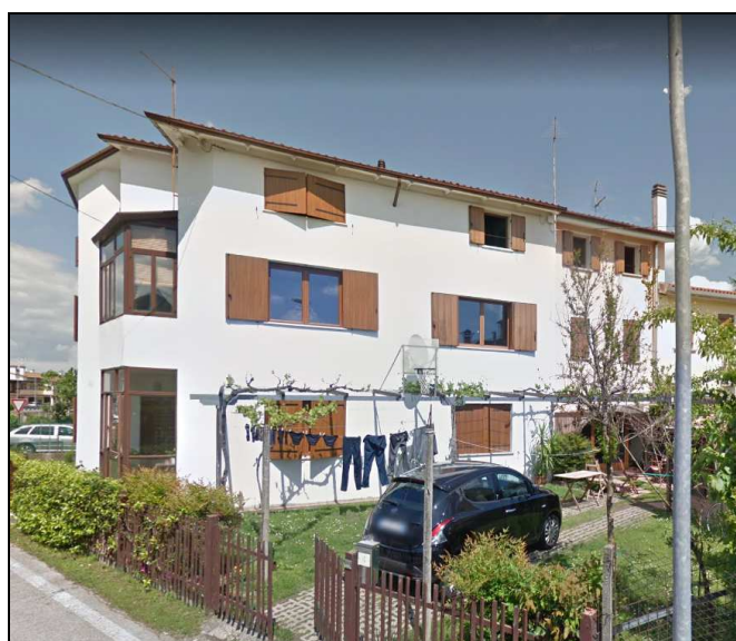
Foto da via Lovarini (Corpo A)
