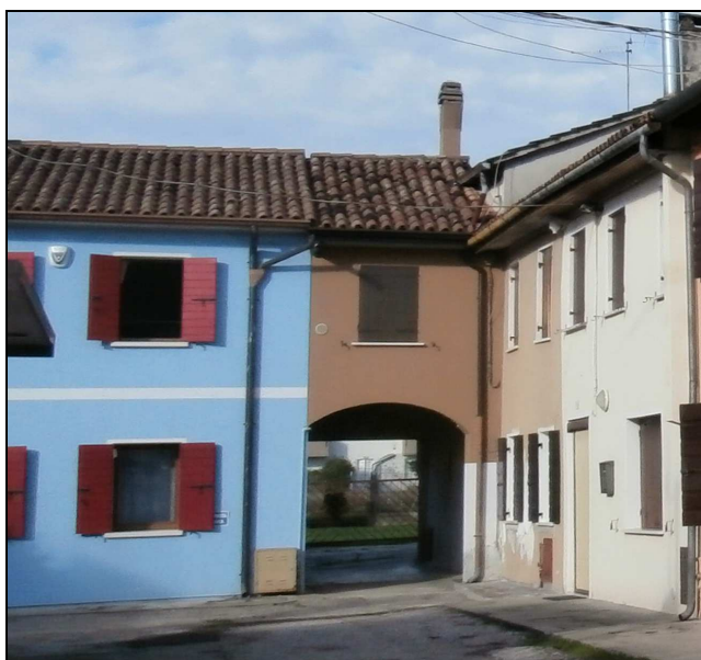
Foto interna da via Lovarini (Corpo A)
