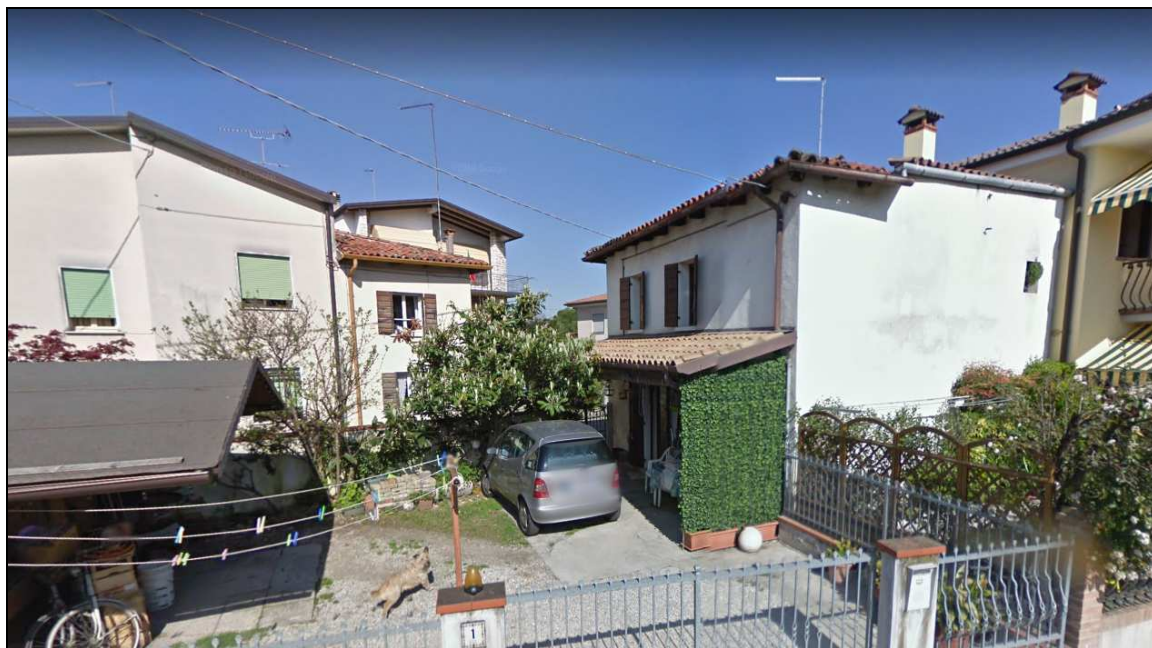
Foto da vicolo Barcador (Corpo A)
