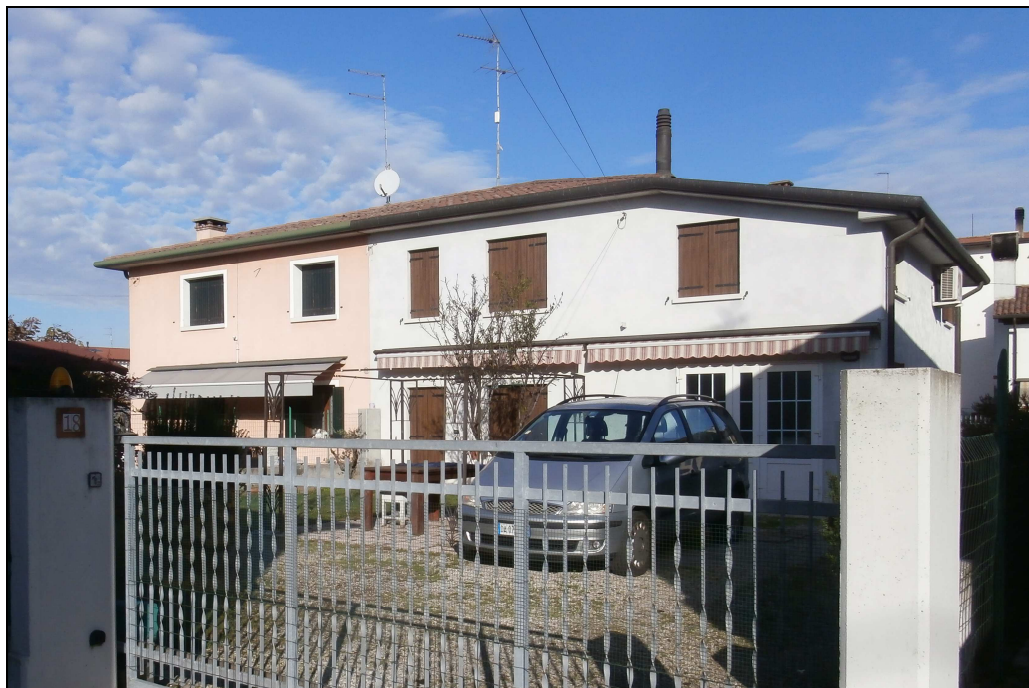
Foto da via Lovarini (Corpo A)
