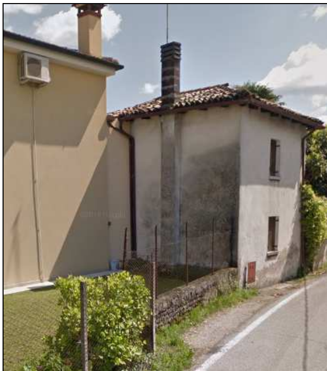
Foto da via Lovarini (Corpo A)
