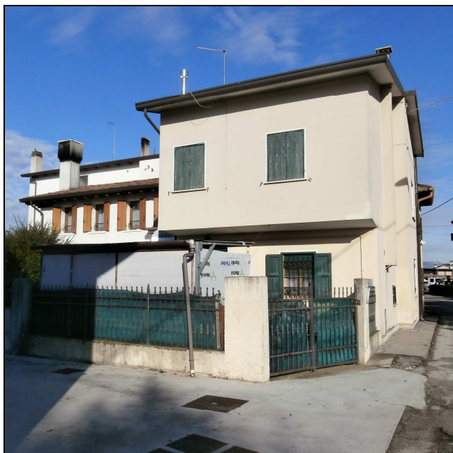
Foto da via Lovarini (Corpo B)
