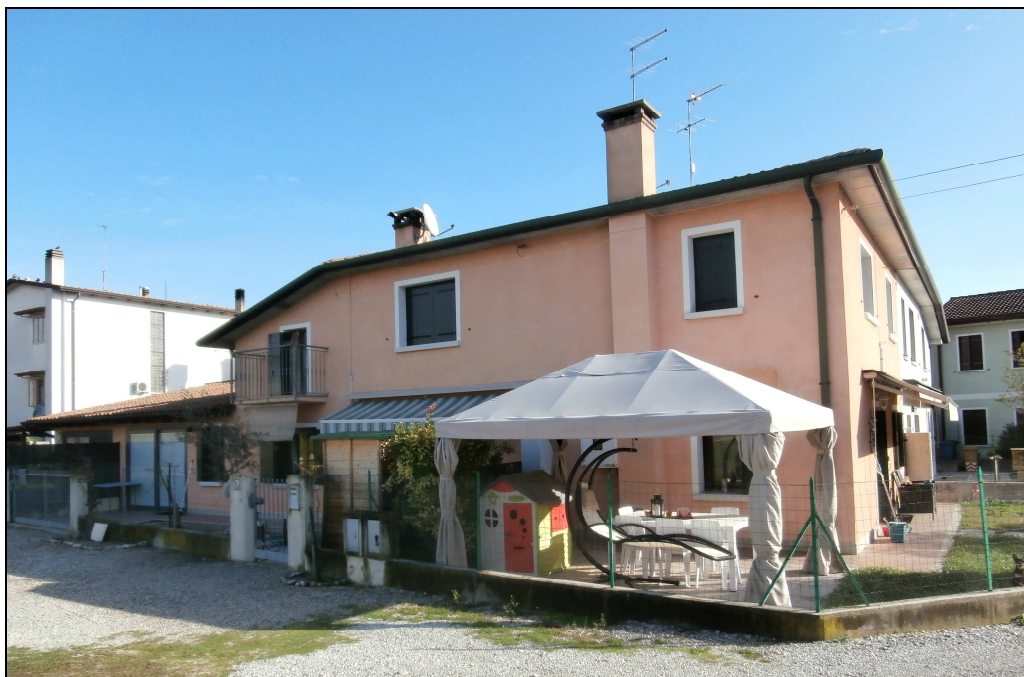
Foto interna da via Lovarini (Corpo A)
