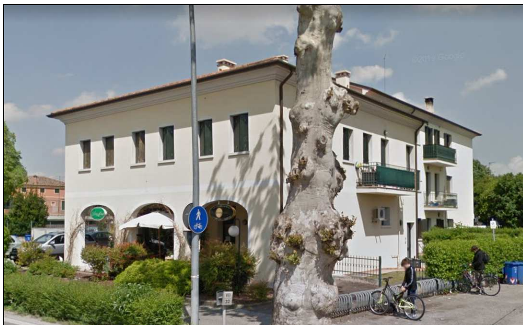
Foto da strada statale Pontebbana
