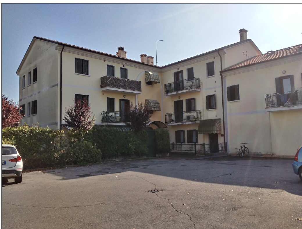
Foto da strada statale Pontebbana
